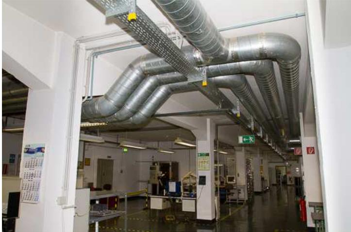
Eine Abluftanlage führt von den Maschinen direkt bis zum Innenhof
