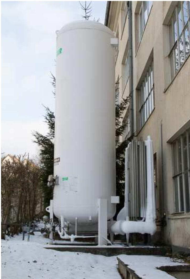
Eine Stickstoffversorgung führt vom Tank direkt in die Fertigung
